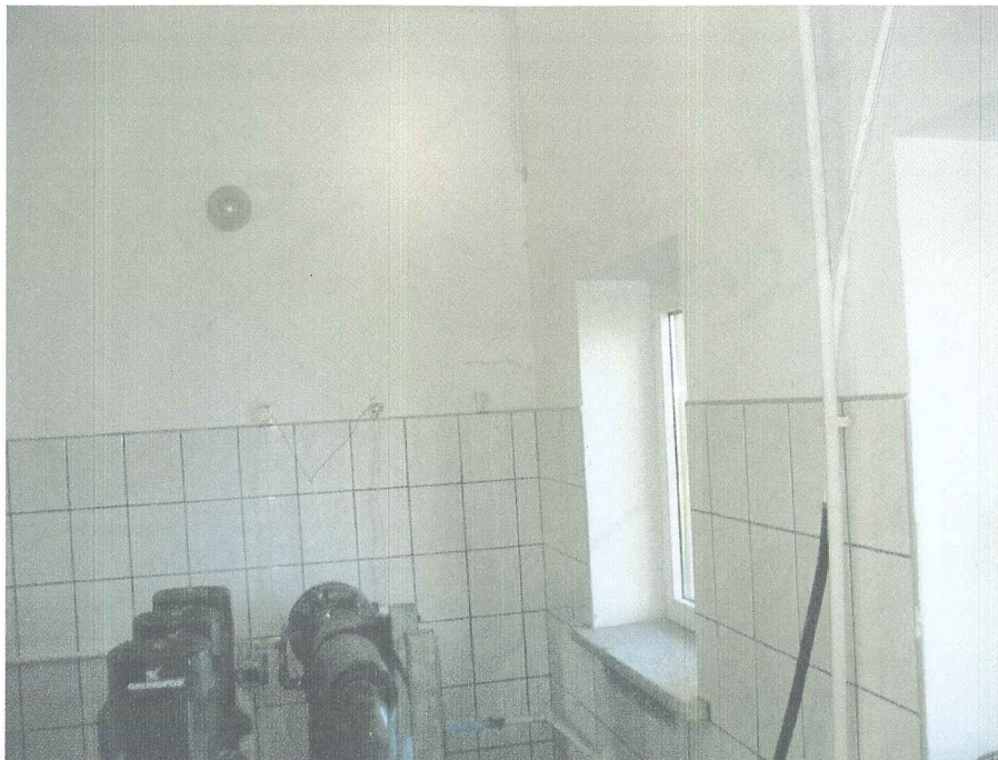
Fot.10 Widok na połączenie części budynku socjalnego i technologicznego po drugiej stronie ściany (od strony zbiorników okrągłych). Na ścianie nad płytkami pojawiło się poziome zarysowanie.
