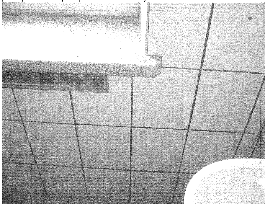
Fot.7 Widok na zarysowanie ściany poniżej okna.
