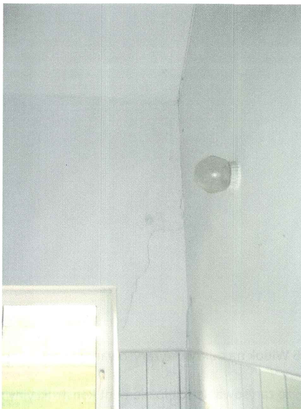
Fot.4 Widok ogólny na zarysowanie ściany przy połączeniu części socjalnej z częścią technologiczną budynku, gdzie są zamontowane urządzenia.
